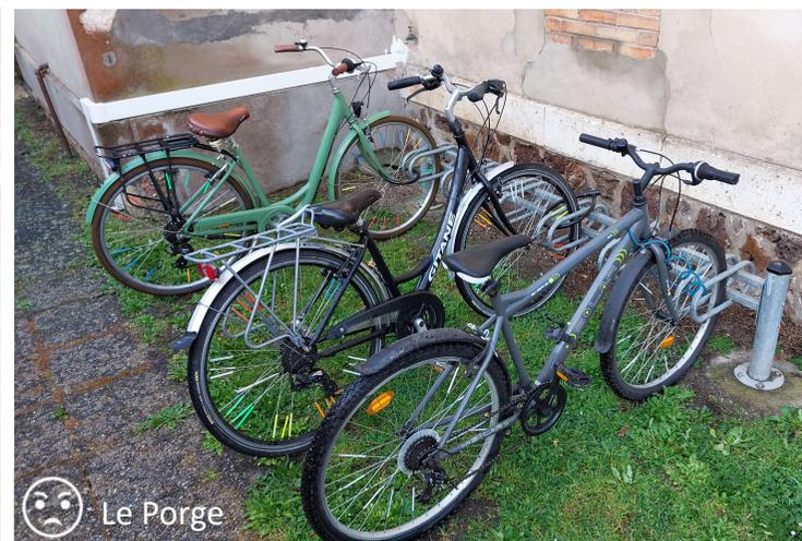
→ Pince-roues à proscrire (pas de sécurisation du cadre, voilage des roues et incompatible avec la sécurisation des VAE et à remplacer par des arceaux vélo permettant de sécuriser l'ensemble du vélo (roues et cadre)
